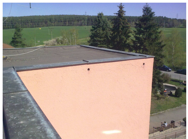
Atikový plech s fasádními větracími otvory
